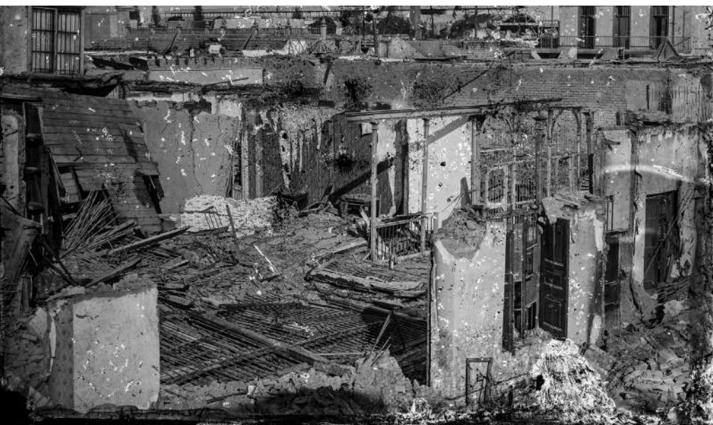
Fotografía de época que evidencia los daños causados a Chorrillos por las tropas chilenas. El balneario de las clases altas limeñas fue reducido a escombros.
