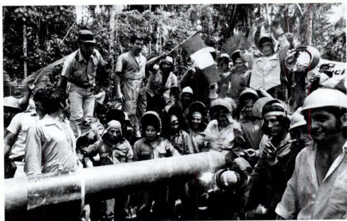
Imagen 11.2. La construcción del oleoducto norperuano en la selva, durante el gobierno de Velasco. Colección del autor.
