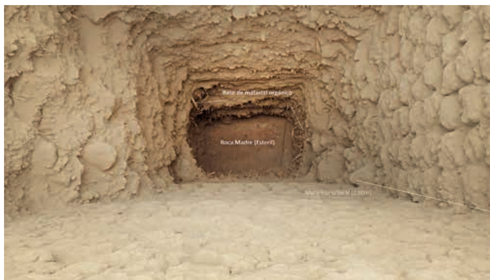
Figura 8. Imagen que muestra el relleno estratigráfico dispuesto sobre la roca madre y previo a la construcción de los muros estructurales.
