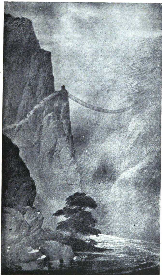
PUENTE SOBRE EL APURIMAC.
