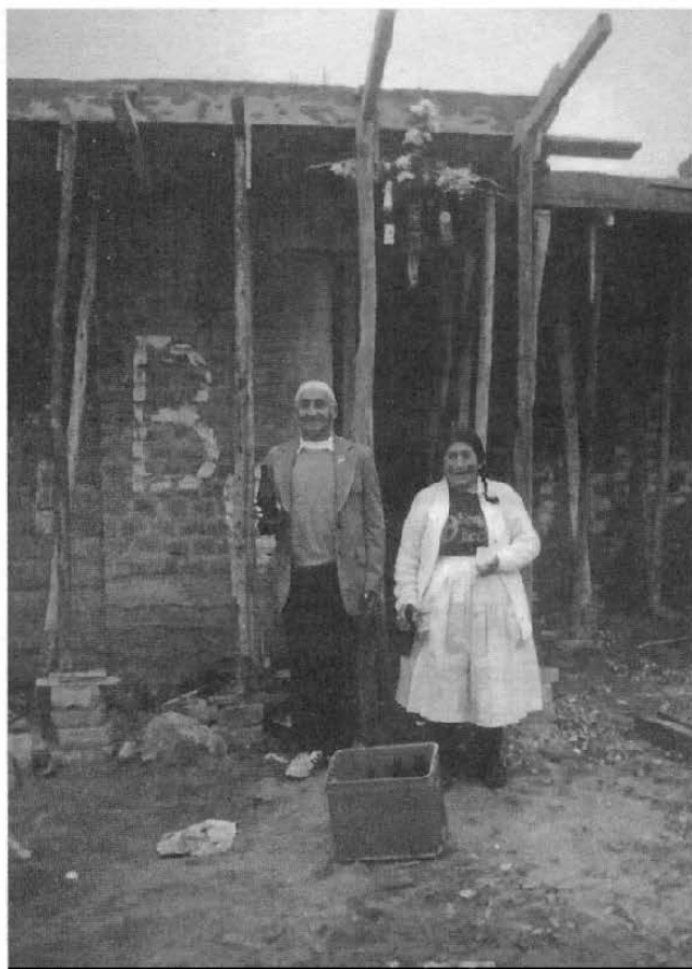
FOTO 2. Mis abuelos Dionicio y Paula, durante la construcción de la casa en Villa María del Triunfo (1985).
