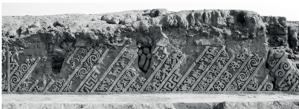
Figura 8. Detalle de relieve en la fachada de la plataforma funeraria del palacio Xllangchic An. En el borde superior puede observarse evidencia de una composición posterior, similar a la que se observa actualmente (foto: Joanne Pillsbury).
