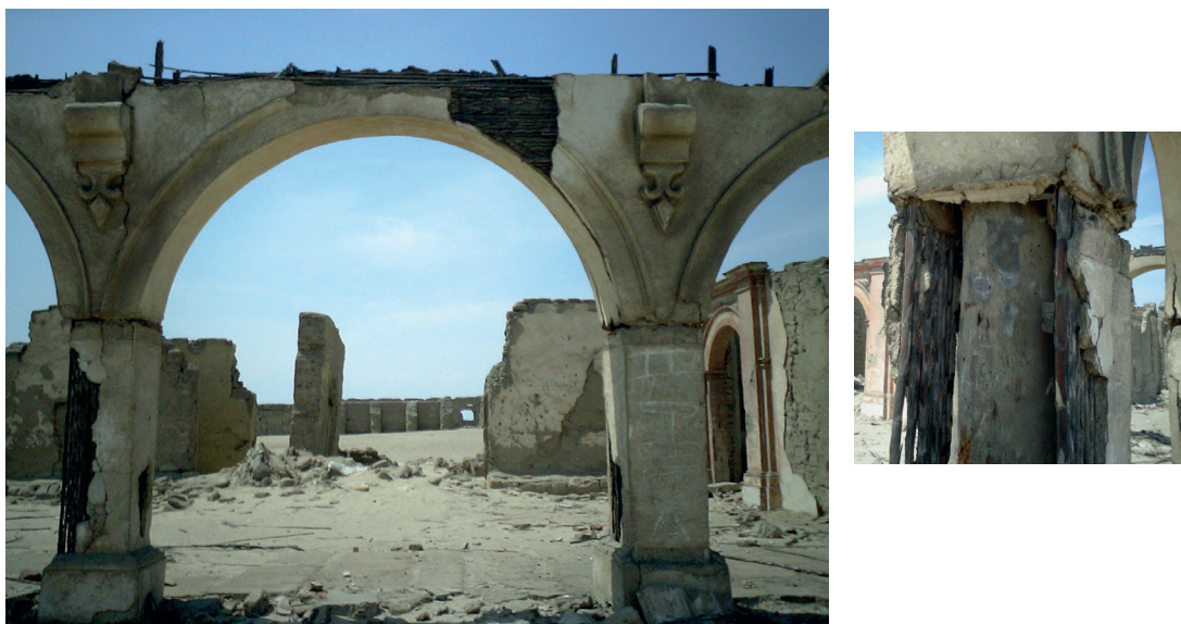
Figura 13. Atrio, Santa Cruz de Lancha. Izquierda: arcos, cuyo enlucido presenta un motivo ornamental de flor de lis (véase la fig. 5); en el área expuesta se aprecia el revestimiento de quincha. Derecha: pilar con poste de palma, revestimiento de quincha y enlucido de acabado (fotos: Joan Morales).
