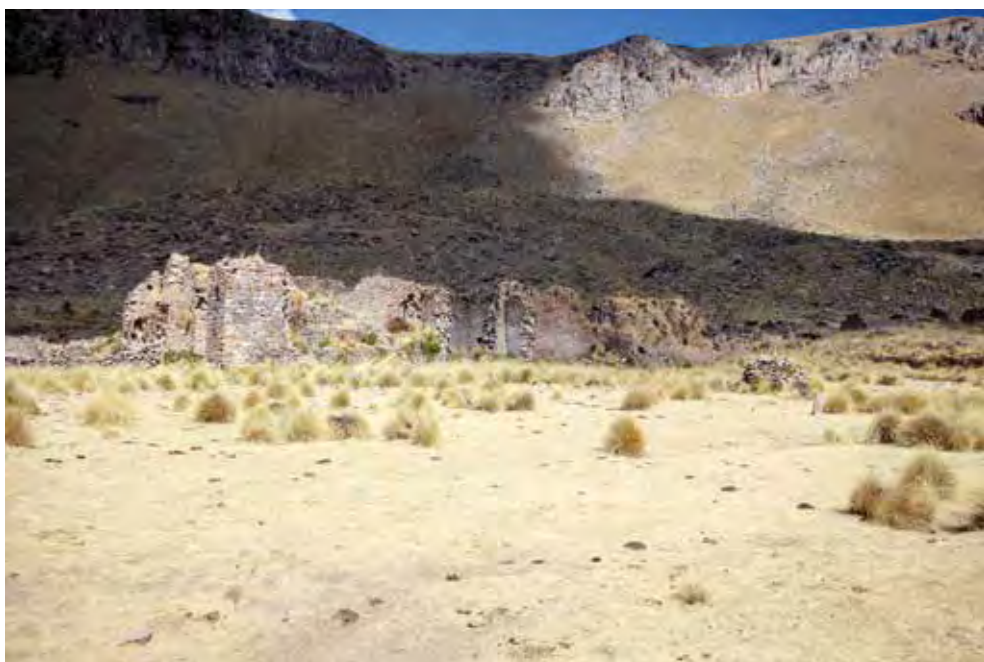
Figura 9. Vista lateral de la iglesia de Mawchu Llacta, desde la esquina sureste de la plaza central. Nota: Nótese el pedestal de la cruz central (derecha).
