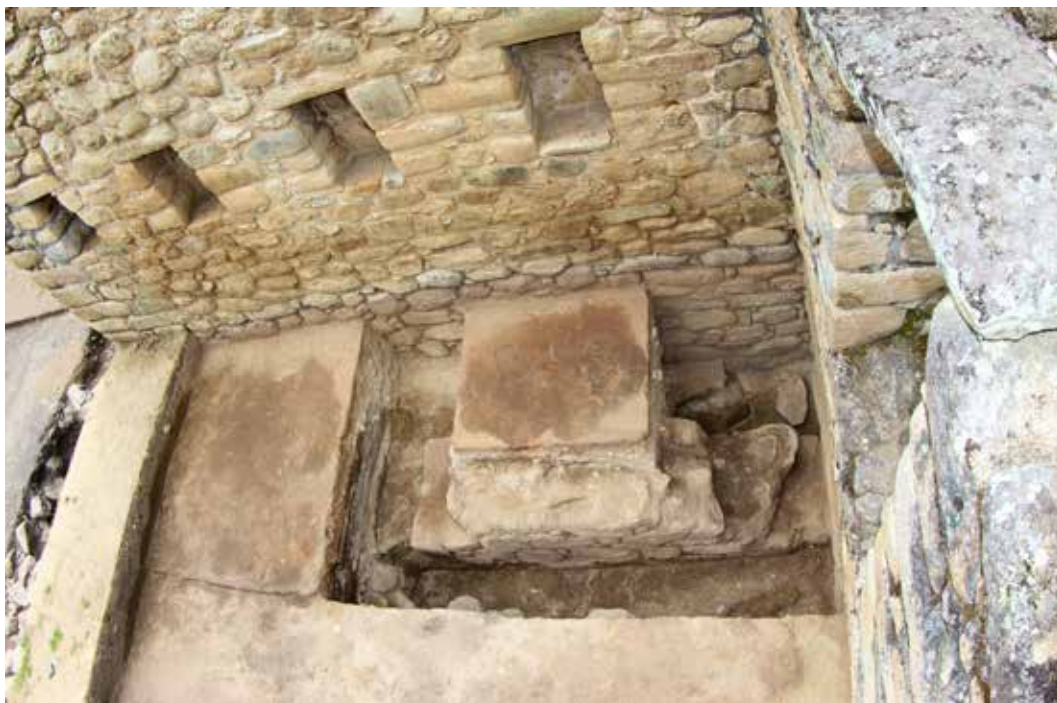
Figura 13. Muro soterrado correspondiente a una primera etapa de construcción del monumento (fotografía: Emerson Pereyra).
