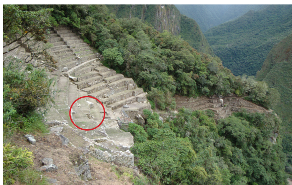
Figura 23. Vista del sector Andenes Orientales I, con la ubicación de la única phaqcha señalada por la circunferencia.
