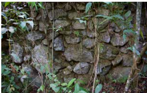
Figura 7. Muro de andén en el MA Ch'askapata (fotografía: José M. Bastante).
