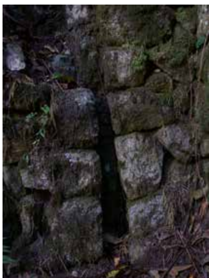
Figura 8. Disipador entre los andenes del MA Killapata (fotografía: José M. Bastante).
