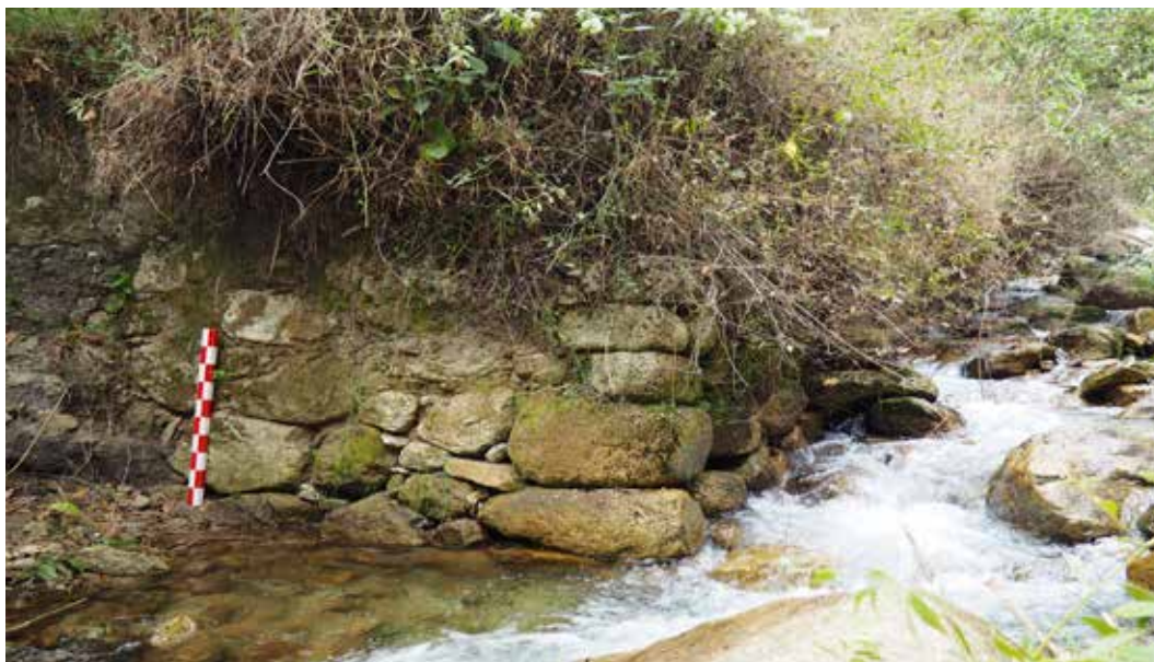
Figura 10. Muro de canalización del riachuelo Chachabamba (fotografía: Dominika Siczowska).
