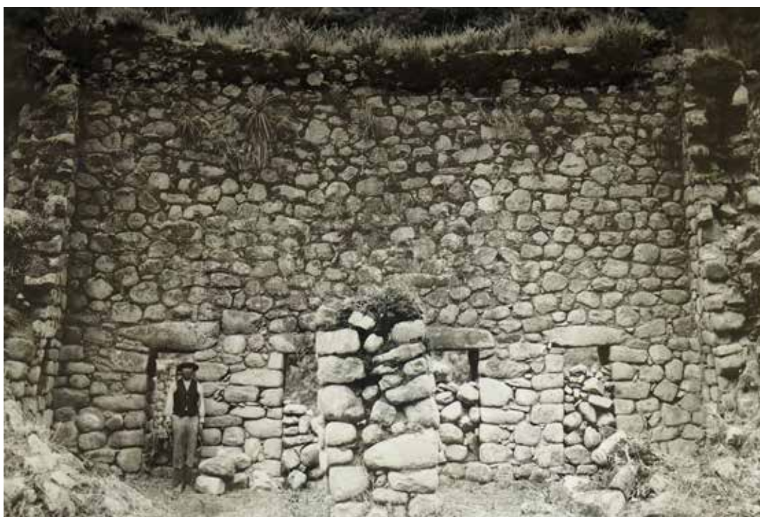
Figura 19. Wayrana doble del sector A con las ventanas tapiadas, 1941 (Fejos 1944).
