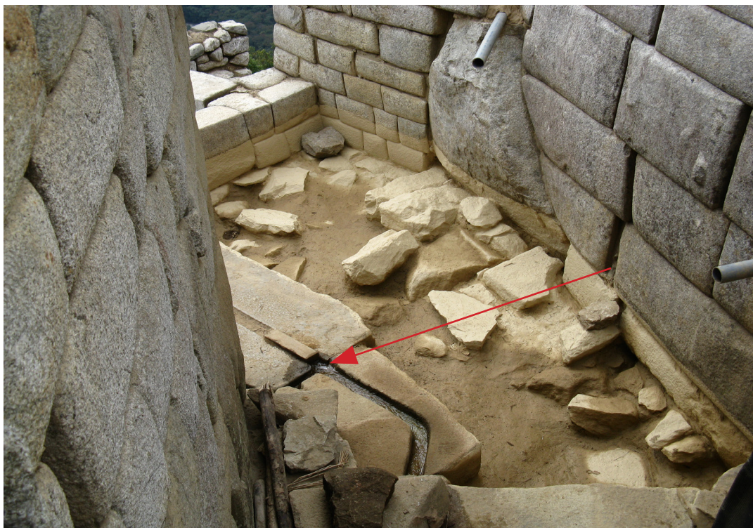
Figura 4. Direccionalidad del separamiento de mampuestos en el Templo del Sol y del separamiento de bloques del canal entre las phaqcha 2 y 3.
