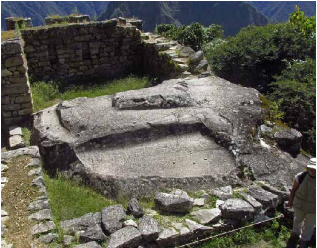
Figura 6. Afloramiento 1 con secciones esculpidas, anexo a una edificación. Presenta toq'o en su soporte; segmento del camino Intipunku-Portada Principal (fotografía: Gori-Tumi, 2016).
