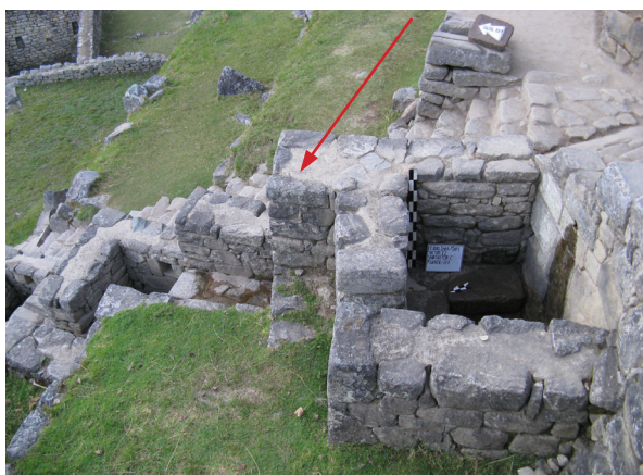
Figura 21. Vista lateral de la phaqcha 7, con el muro que impide el acceso a ella señalado por la flecha.
