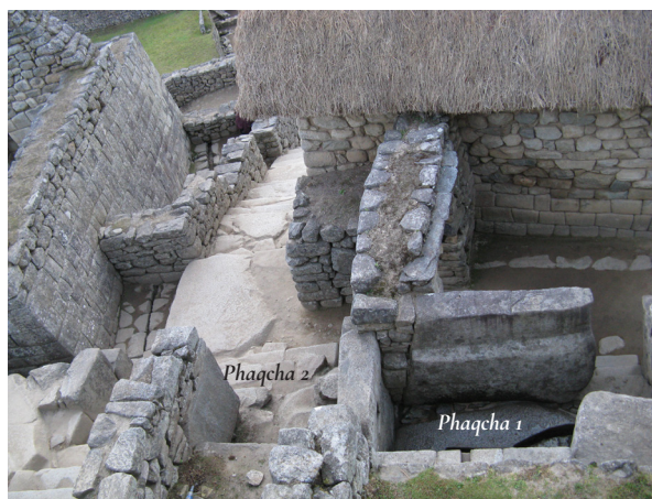
Figura 27. Vista en planta de la phaqcha 1A (conjunto 15), que se hallaba en proceso de construcción.
