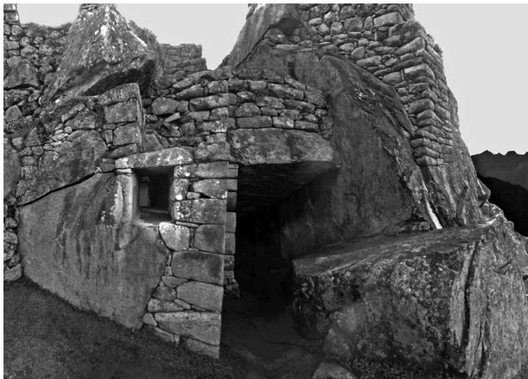
Figura 2. Intimachay. Vista de la cueva desde el lado este, indicando la ventana E, especialmente construida para observaciones astronómicas (fotografía: Jacek Kościuk).
