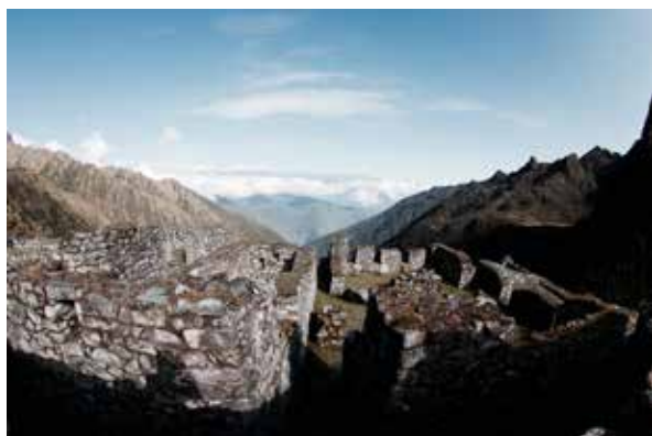
Figura 24. Recintos del MA Sayaqmarka (fotografía: José M. Bastante).
