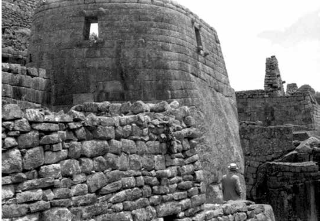
Figura 1. El Torreón en primer plano, frente sureste; 1956.
