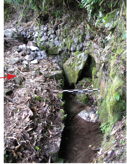
Figura 2. Vista general del canal de captación, donde se puede apreciar el ancho que registra.
