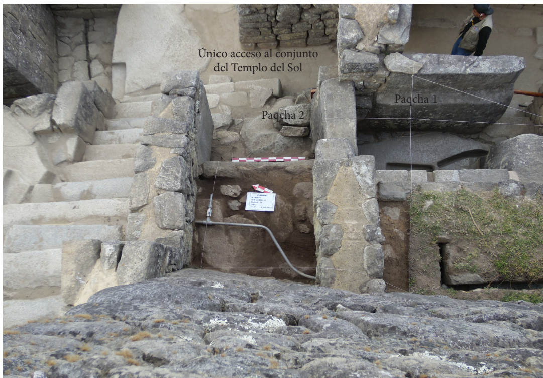
Figura 7. Vista en planta de la phaqcha 1A en proceso de construcción; carece de articulación con el canal de abastecimiento.
