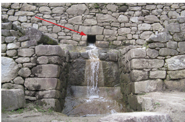
Figura 24. Phaqcha del sector Andenes Orientales I articulada al canal de drenaje de ducto cerrado a través del cual es alimentada.
