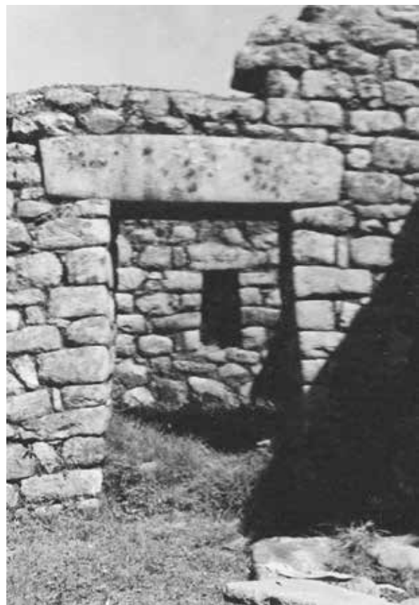
Figura 11. Vano con dintel de piedra; 1963.
