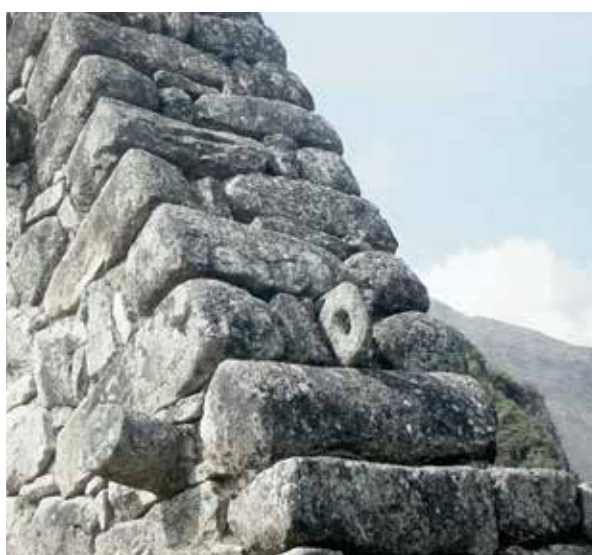
Figura 9. Mojinete mostrando clavija y argolla para fijación de la cubierta, 2006.
