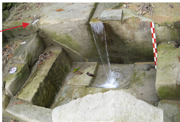
Figura 14. Vista frontal de la pha qcha 1 (sección E) del sec- tor Andenes Orientales IV.
